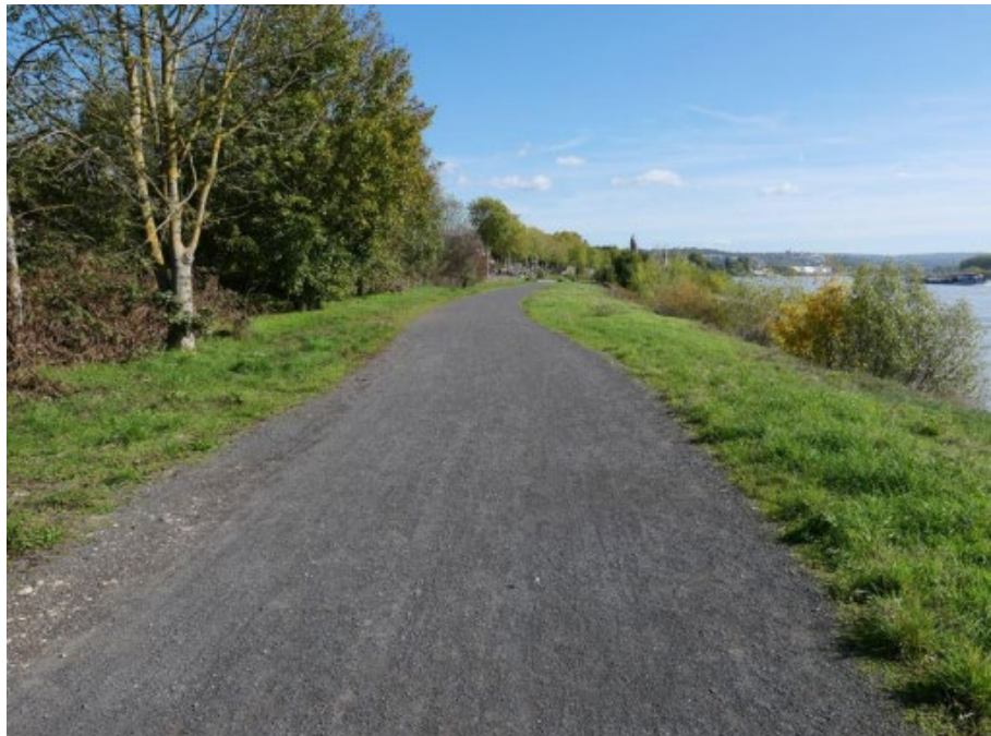
Abbildung 5-7: Beispiel für einen Betriebsweg mit dem Baustoff Balastan 1516
