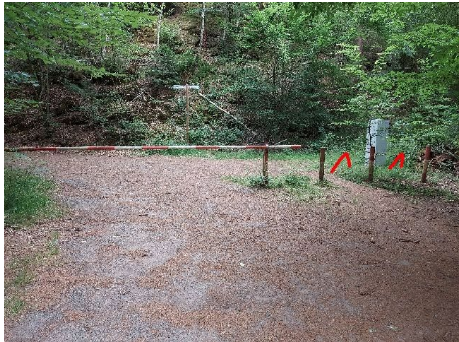
Abbildung 5-31: Beispiel für eine mögliche Maßnahmen an Schranken (Betriebsweg Höhe K18; Lambrecht (Pfalz))
